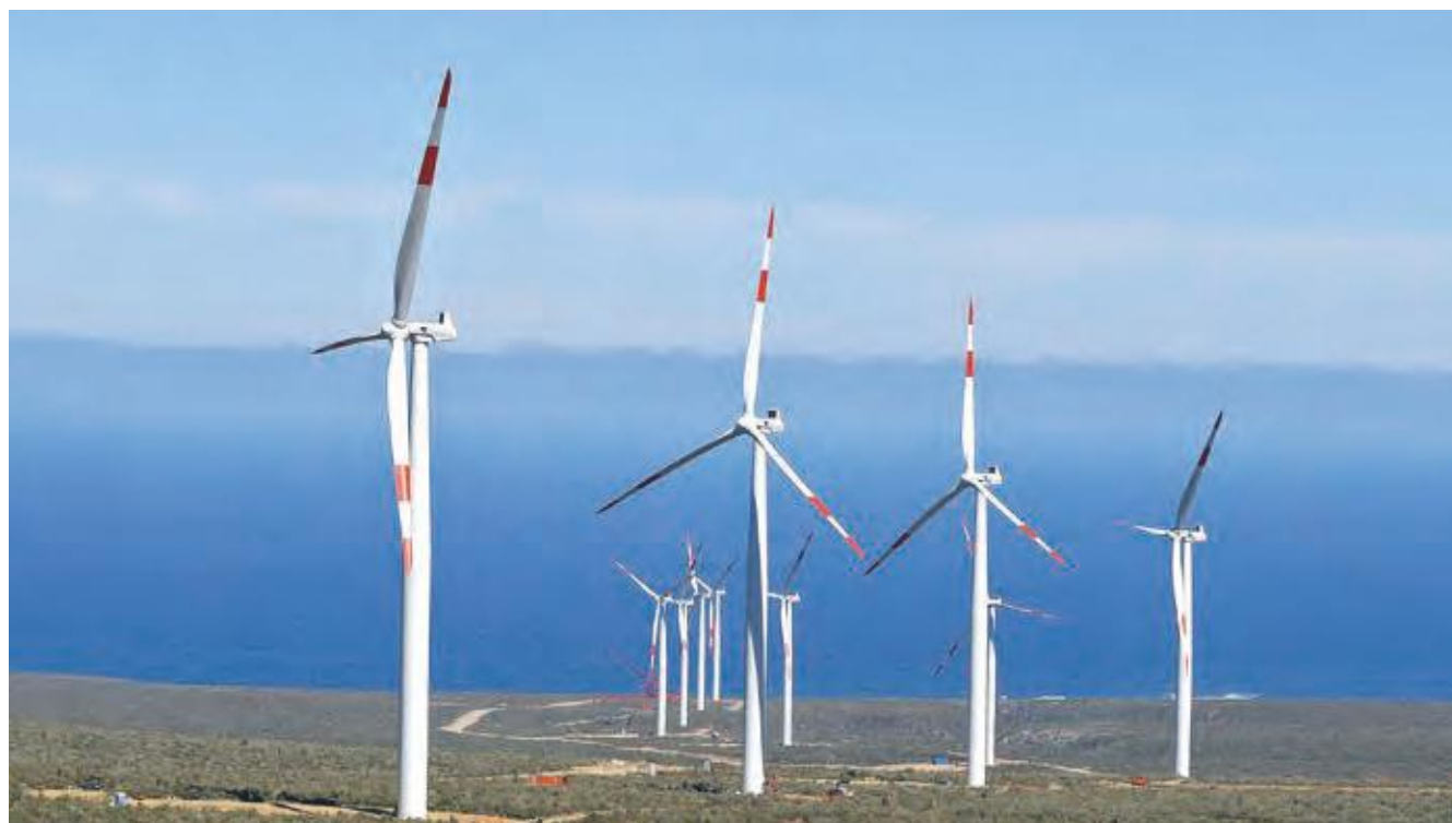
Parque Eólico Carrelá.
