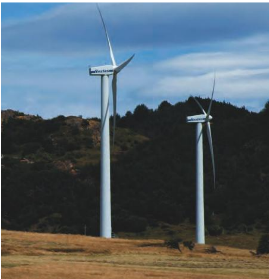
Carretera Austral, Parque Eólico.
