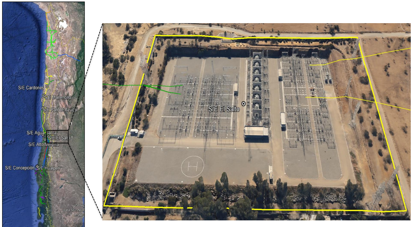
Figura 9.37: Ubicación de la S/E El Salto.
