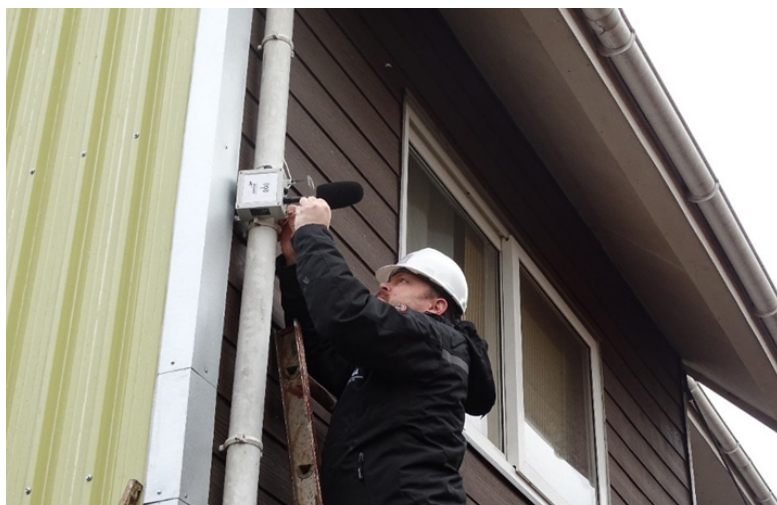
Instalación de sensor de ruido en Concepción, 2017
