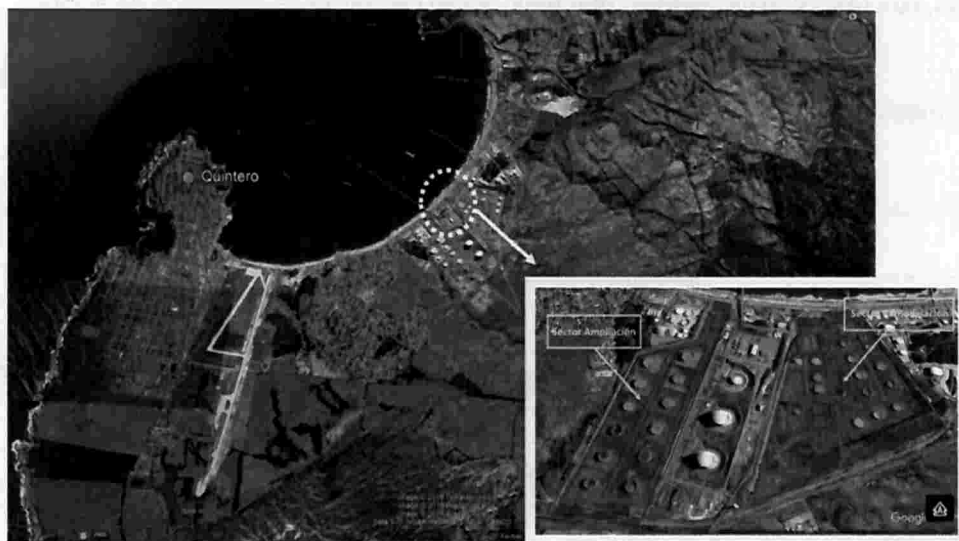
Figura N° 2 – Sectores del Terminal Marítimo de Quintero
