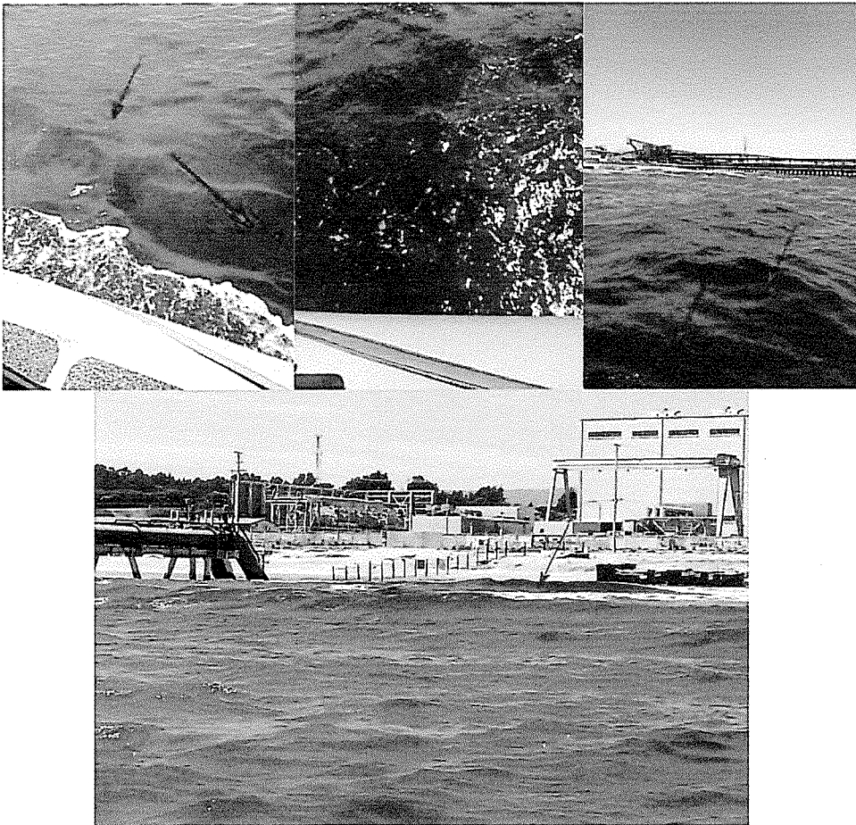
Figura 32. Fotografías obtenidas durante el levantamiento con lancha hidrográfica SHOA en noviembre de 2019. Arriba: se observa material negro (indicado por flechas) que se desplaza conforme al oleaje, es decir, de oeste a este, por el fondo marino y a niveles intermedios. Abajo: el material alcanza la costa, observándose las olas oscuras en la zona de rompiente (flecha).
