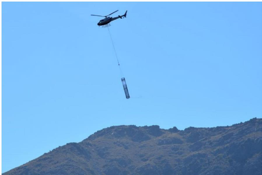
Helicópteros que cargan materiales para construcción de línea de transmisión eléctrica. Foto cedida por Mario Aguirre Montaldo.
